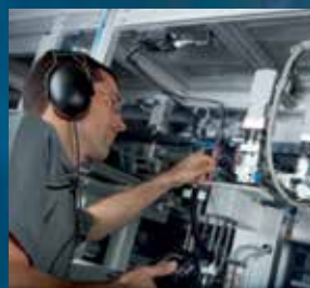
Wykrywanie i eliminowanie nieszczelności
