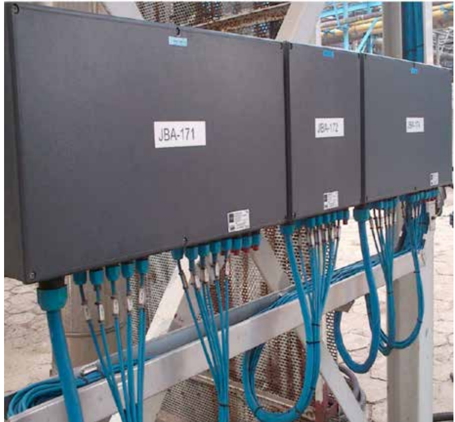
Wydział syntezy amoniaku – Grupa Azoty PUŁAWY. Strefa zagrożenia wybuchem – zastosowanie przewodów IB-BiT 500°C
